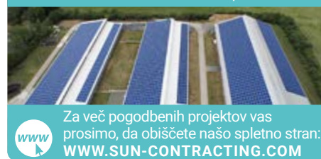
NEMČIJA Laußnitz 710,64 kWp
