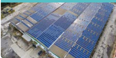
NEMČIJA Dahlen 749,25 kWp
