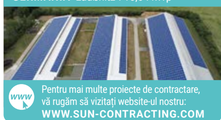
GERMANIA Laußnitz 710,64 kWp
