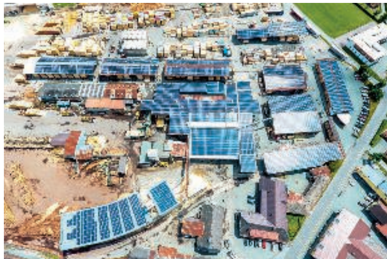
Das Sägewerk Hasslacher in Hermagor (K) hat eine der größten Aufdachanlagen in Österreich mit einer Leistung von 1,5 Megawattpeak
